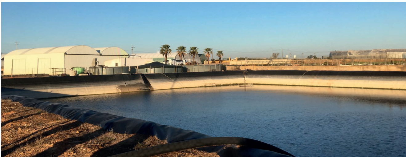
Figura 1 – Charca impermeabilizada para recuperação da drenagem de culturas em substrato e das águas pluviais, para reutilização (Bayflor Sociedade Agrícola S.A.).
