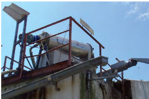
Figura 30. Separador de prensas de parafuso (Fonte: Brendal et al., 2015)
