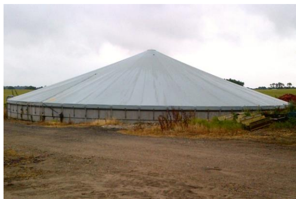
Figura 4 – Cobertura cónica de proteção rígida num tanque de chorume 7
