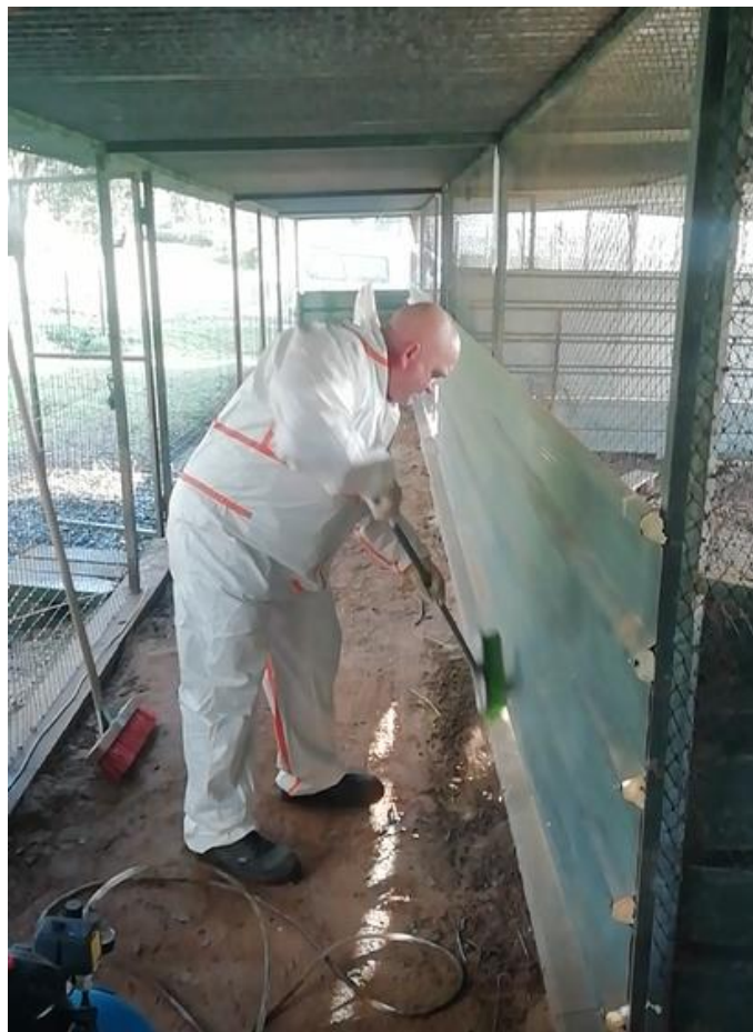
Artur Lopes prepara as superfícies para a pintura.
