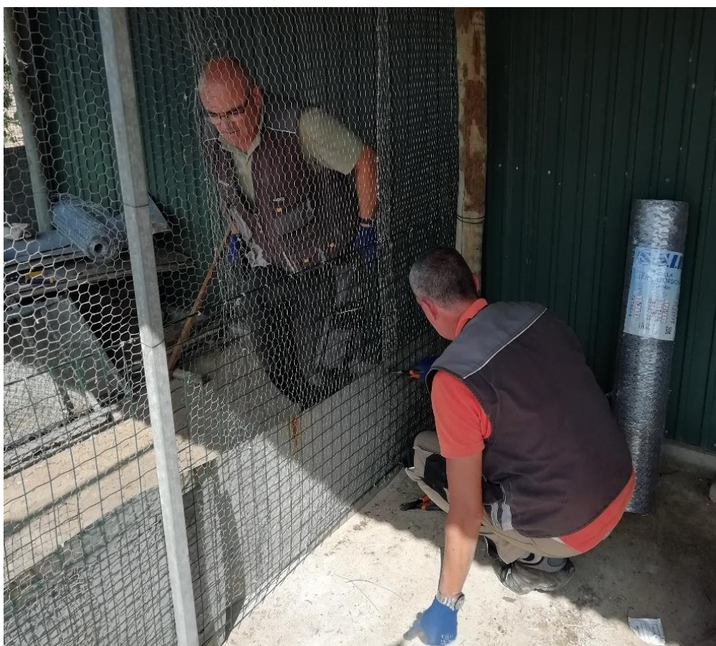
José Lopes e Paulo Apolo a iniciar as instalações das vedações.
