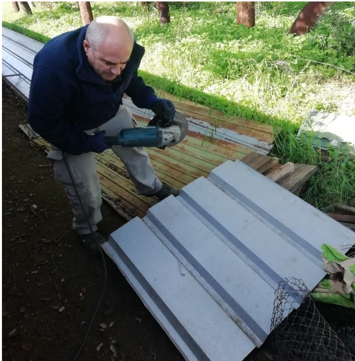
José Lopes a cortar chapa com rebarbadora para completar uma vedação.
