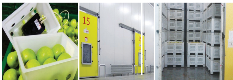
Figura 17 – Equipamento para deteção da fluorescência dos frutos em atmosfera controlada dinâmica (cima), câmaras de conservação (baixo, esq.) e distribuição dos paloxes no seu interior (baixo, dir.)
